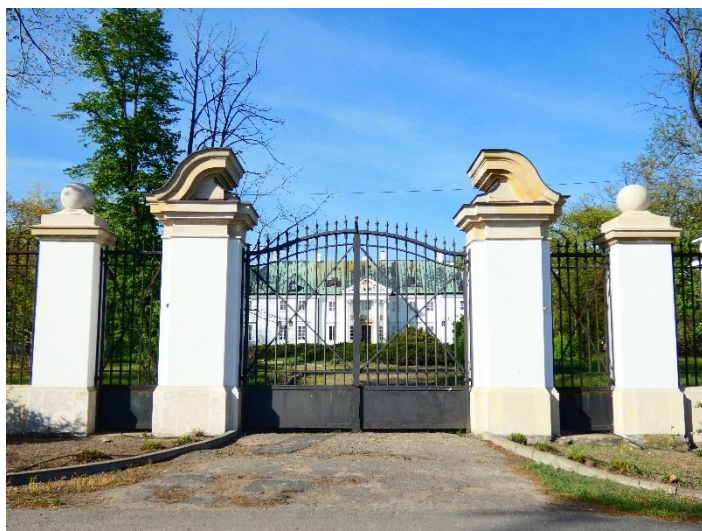
Fot. 16. Ogrodzenie w Luszyńie
