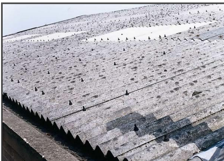
Rysunek 1. Dach pokryty azbestową płytą falistą
