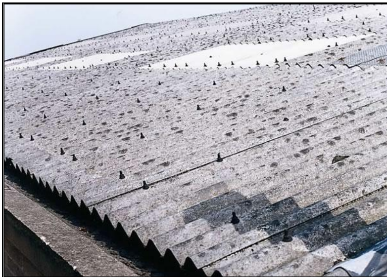
Rysunek 1. Dach pokryty azbestową płytą falistą
